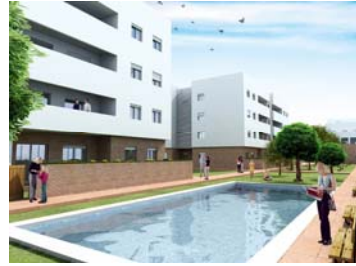
45 VIVIENDAS. PLURIFAMILIARES ECUJA. SEVILLA
