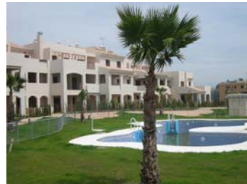
25 VIVIENDAS. (RESORT) CASARES. MALAGA
